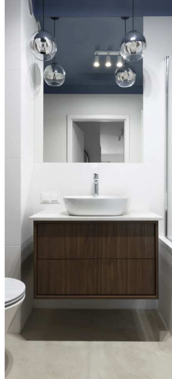
Dobór i montaż oświetlenia
